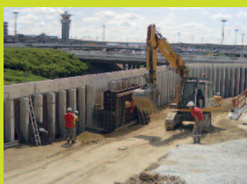
Remblaiement derrière un ouvrage d'art
