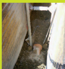
Enrobage d'une canalisation en grès et remblaiement de la tranchée
