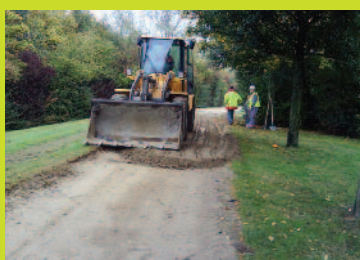
Mise en œuvre de l'URBASOL en sous-couche d'une piste cyclable
