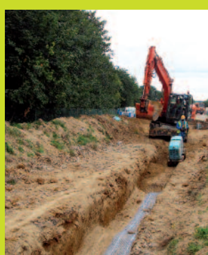
Tranchée d'une conduite d'eau potable
