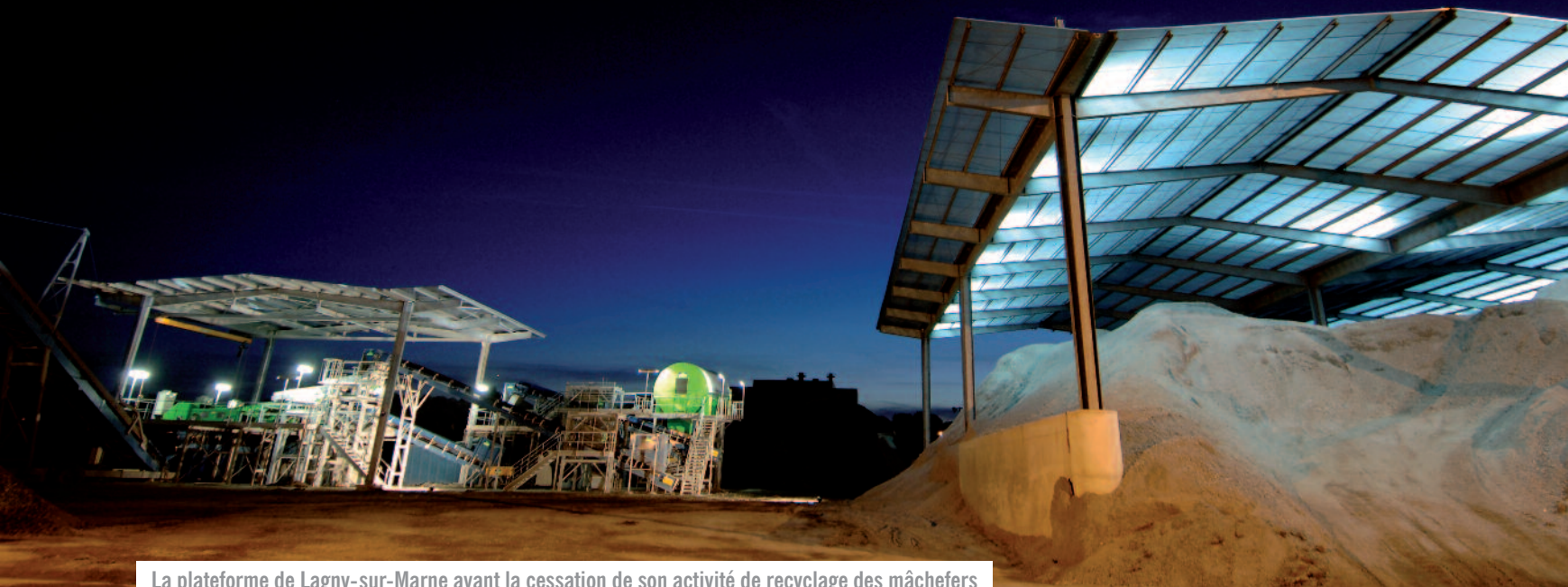
La plateforme de Lagny-sur-Marne avant la cessation de son activité de recyclage des mâchefers
