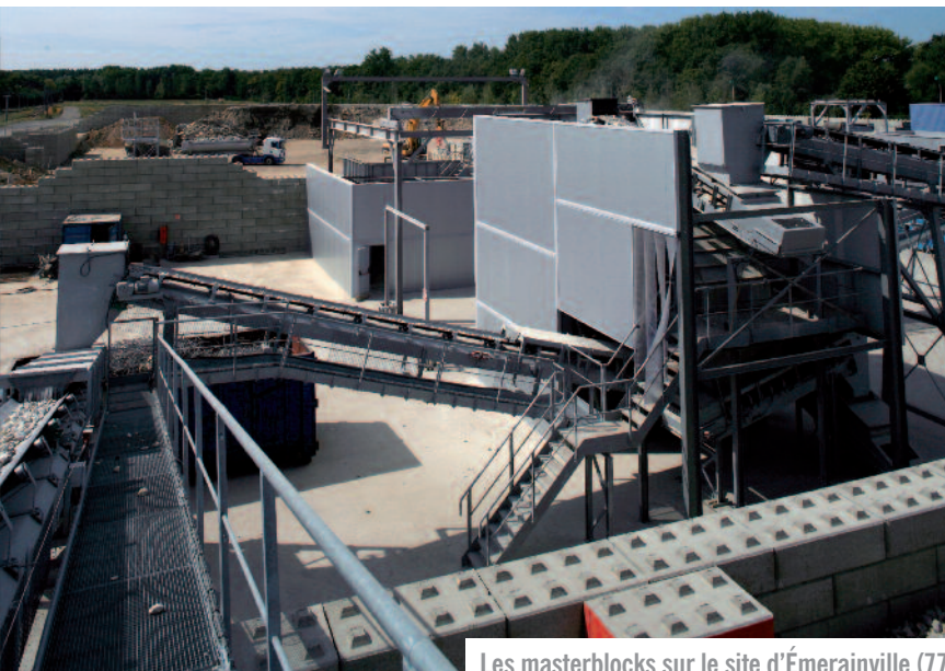
Les masterblocks sur le site d'Émerainville (77)
