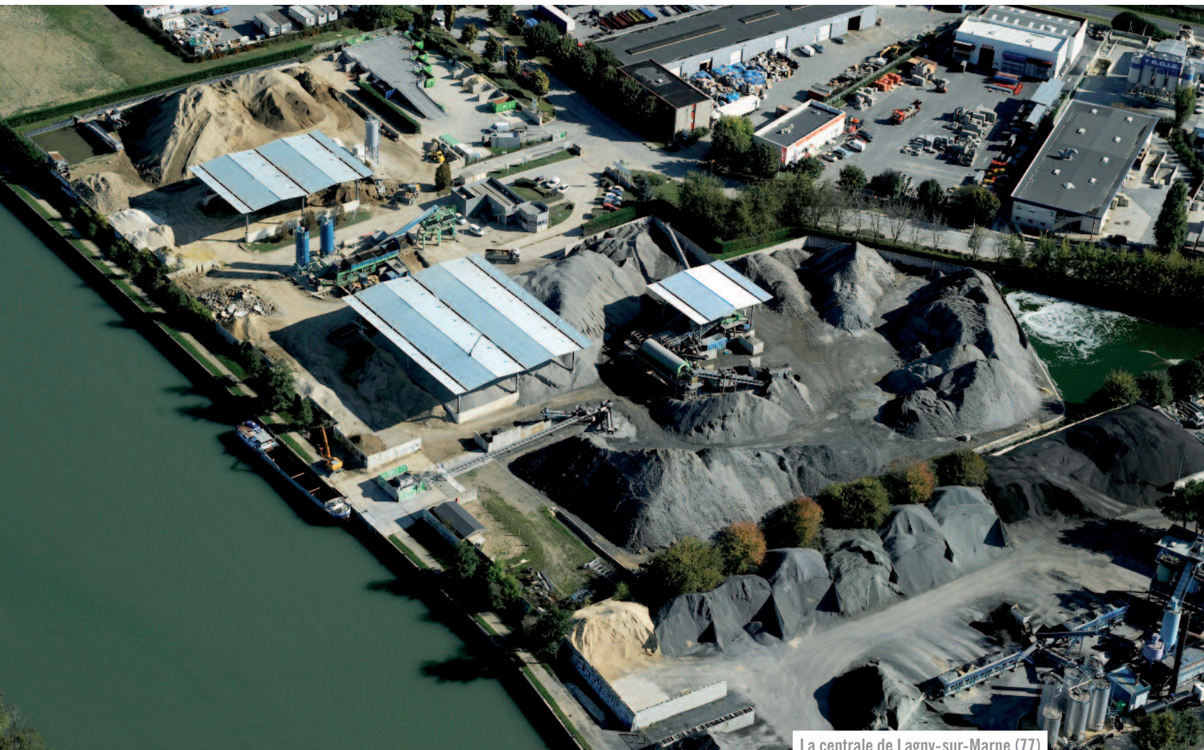
La centrale de Lagny-sur-Marne (77)
