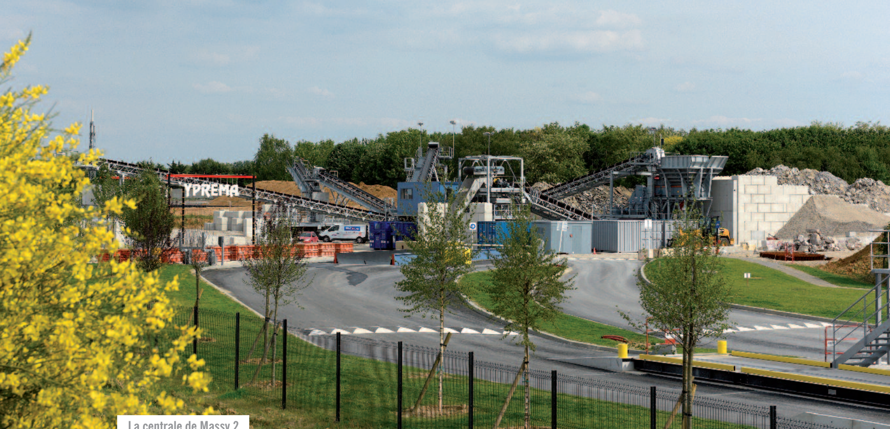
La centrale de Massy 2
