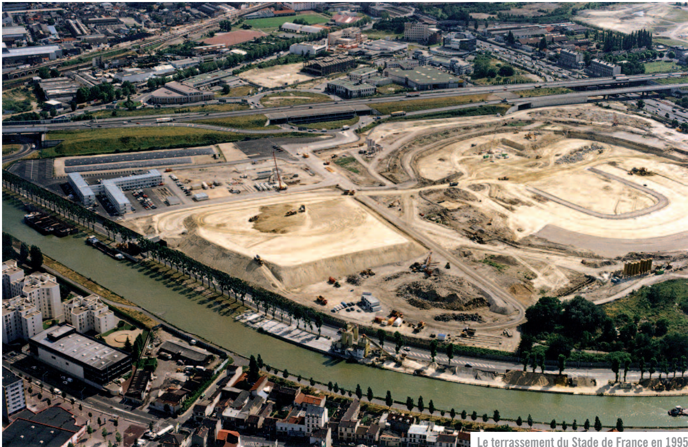
Le terrassement du Stade de France en 1995
