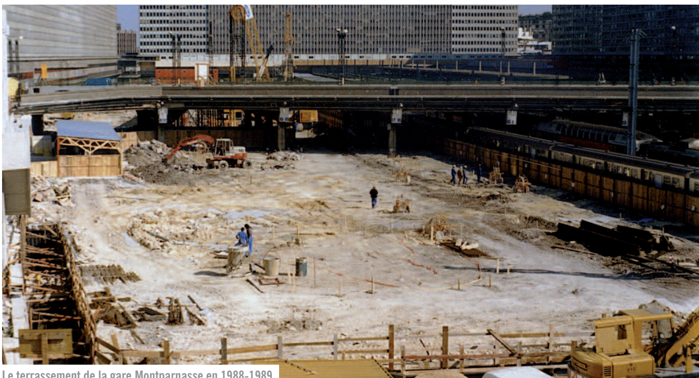
Le terrassement de la gare Montparnasse en 1988-1989
