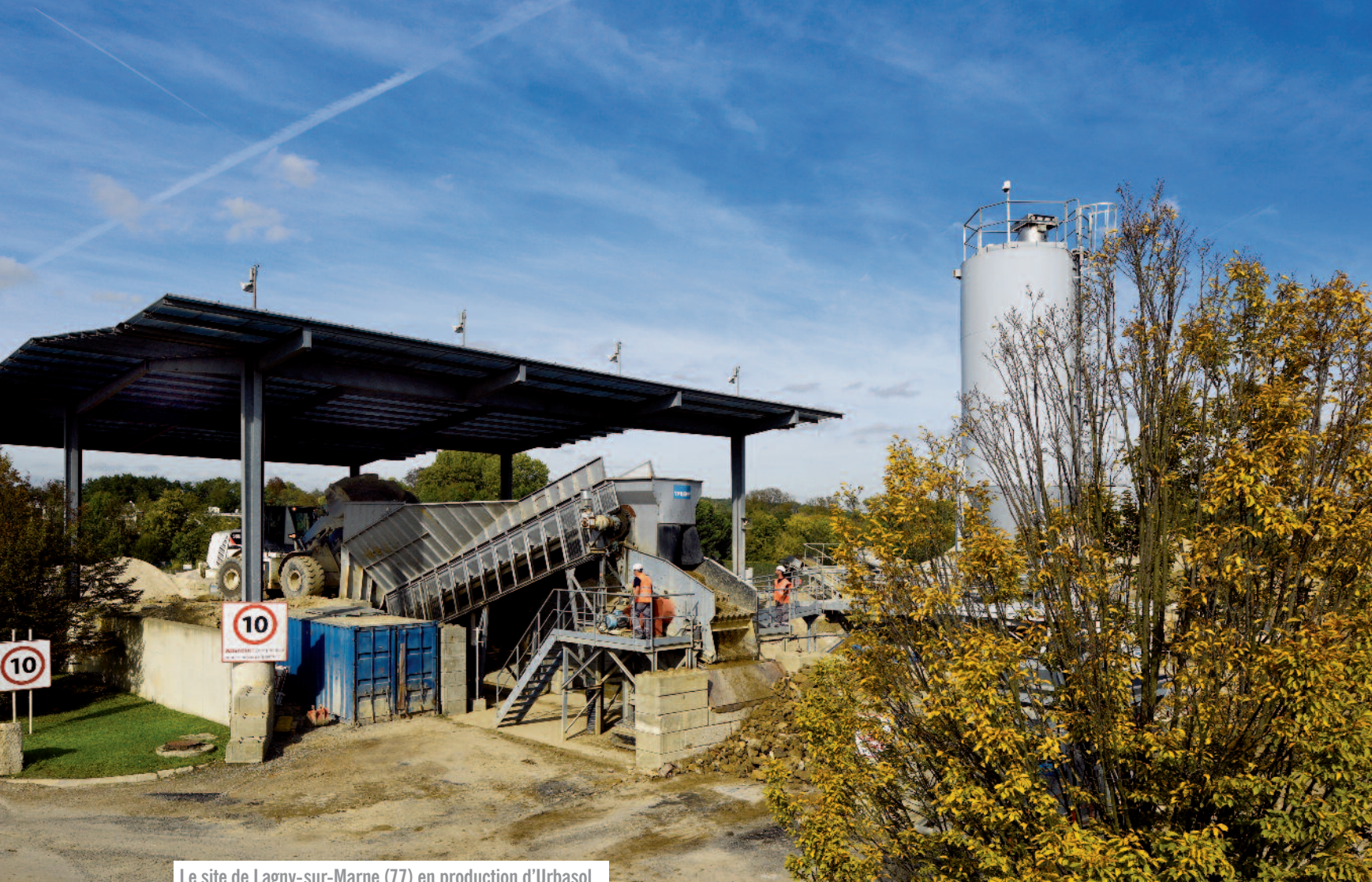
Le site de Lagny-sur-Marne (77) en production d'Urbasol
