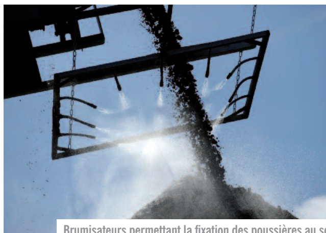
Brumisateurs permettant la fixation des poussières au sol
