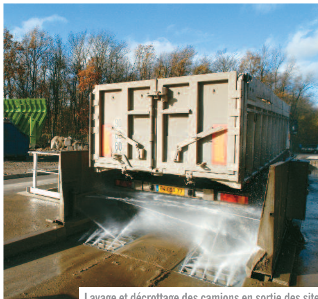
Lavage et décroûtage des camions en sortie des sites
