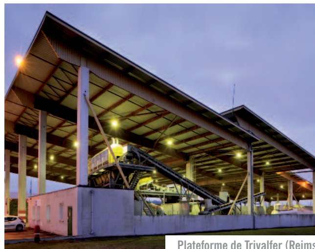
Plateforme de Trivalfer (Reims)
