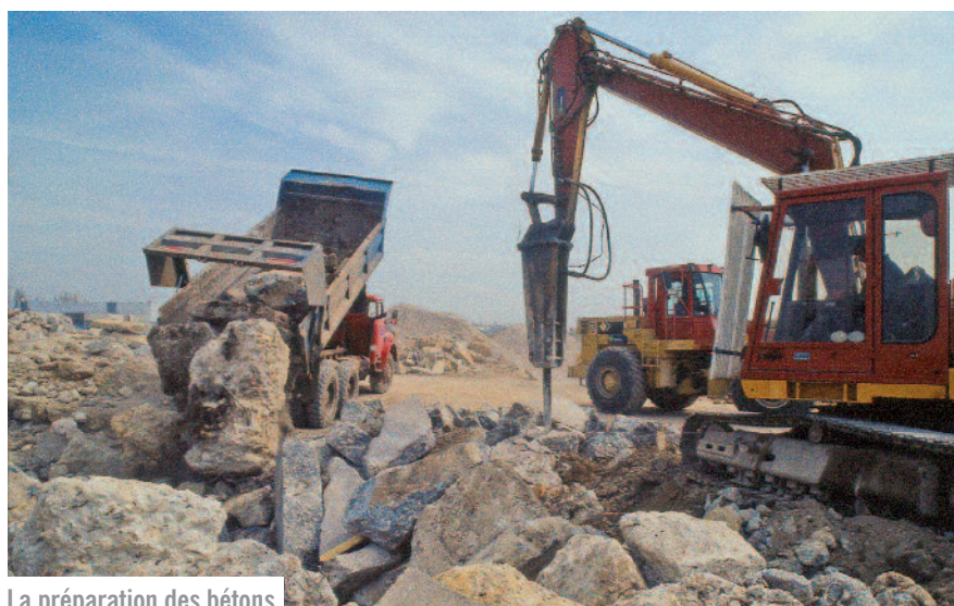
La préparation des bétons
