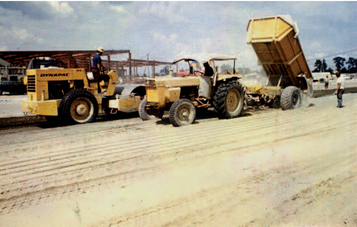
En 1975, traitement de sol en place, en Pologne
