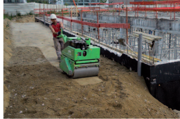
Remblai de bâtiment
