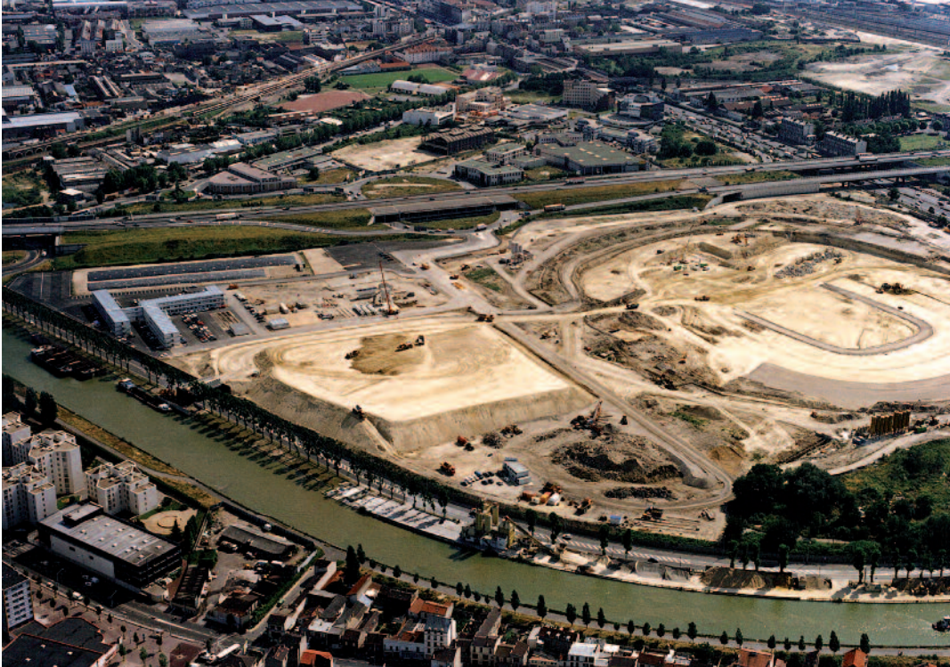
Le terrassement du Stade de France, en 1995
