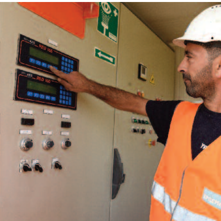
Pilotage de l'installation
