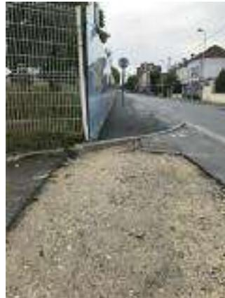
Grave Béton Concassé 0/31.5 après mise en œuvre
