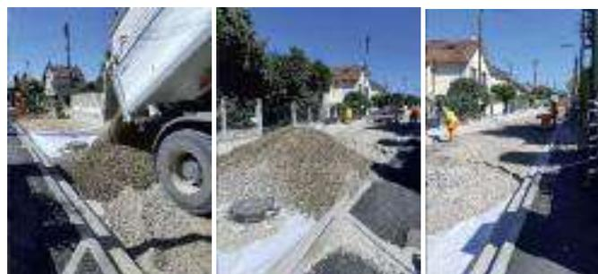
Le déchargement de la Grave Béton Concassé 0/31,5 et sa mise en œuvre
