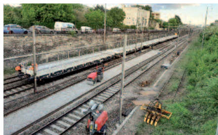
Vue après comblement de la voie en Grave SNCF YPREMA
