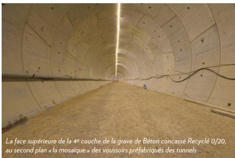
La face supérieure de la 4<sup>e</sup> couche de la grave de Béton concassé Recyclé 0/20, au second plan « la mosaïque » des voussoirs préfabriqués des tunnels
