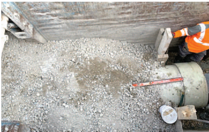
Tranchée après lit de pose en cailloux, enrobage de la canalisation en gravillons et remblais de la tranchée en grave 0.31,5.
