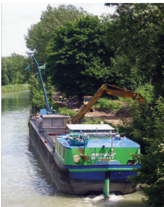
Guily-Glaz : déchargement de la grave industrielle
