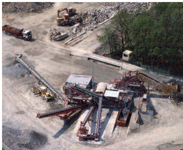
Les installations HAZEMAG en 1994
