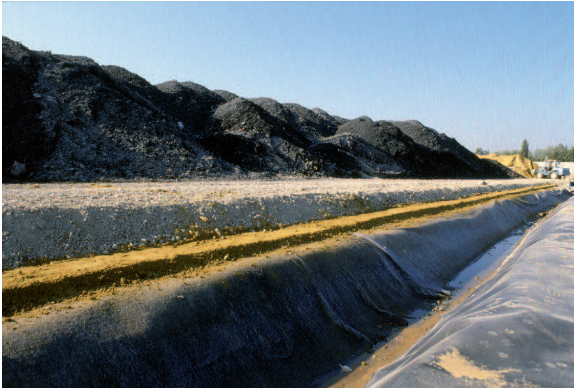
L'étanchéité de la plateforme de stockage de mâchefers à Lagny-sur-Marne (77)
