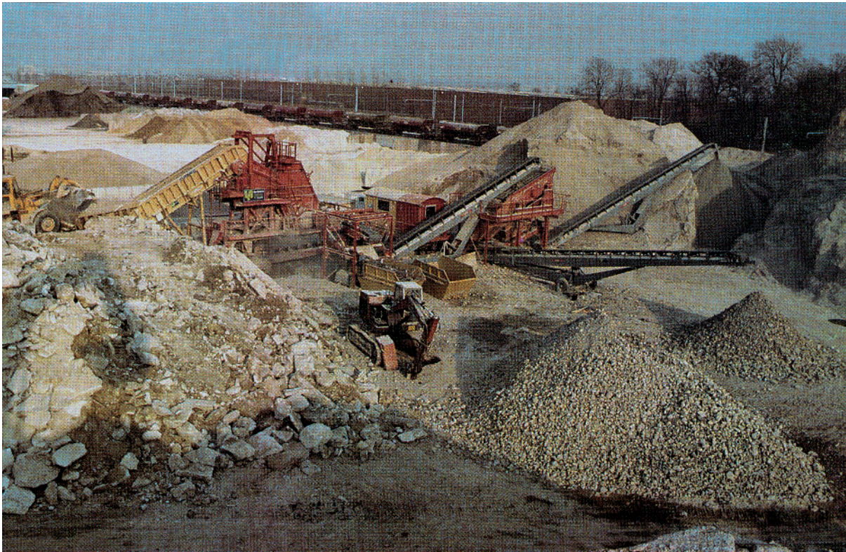
Installation HAZEMAG en 1984
