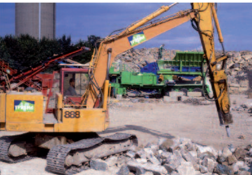
La pelle hydraulique avec BRH
