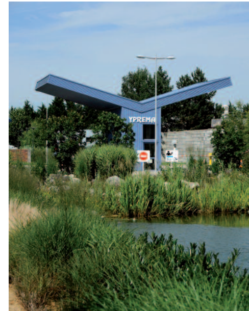
Le site d'Emerainville : les réalisations sont aussi belles que peuvent l'être les projets.
