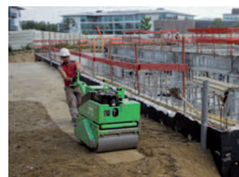
Remblai de bâtiment
