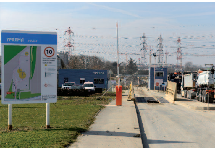
Le poste de contrôle des chargements entrants
