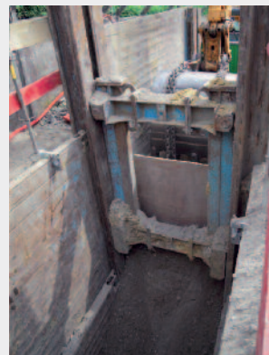
Tranchée remblayée en Grave Primaire 0/31,5
