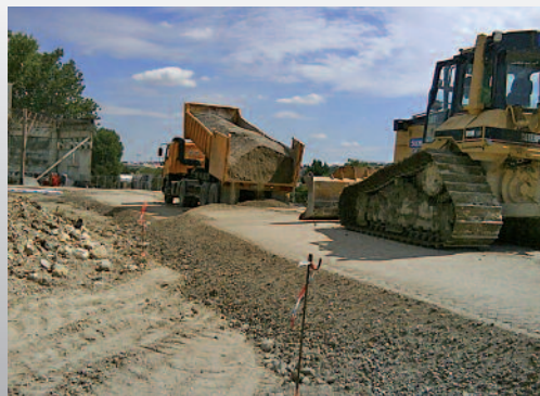
Livraison de Grave Concassée Industrielle compactée sur deux couches de 25cm
