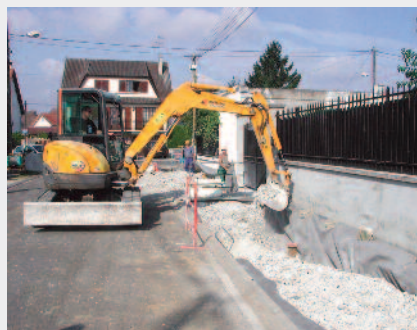
Cailloux de Béton 30/70
