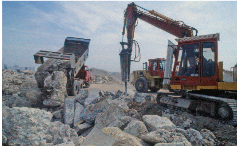
La préparation des bétons
