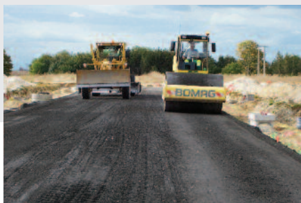
Mise en œuvre de la grave de mâchefers sur Reims Métropole (51)
