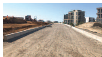
Déviation A14/ A86 à Nanterre (92)
