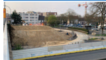
Aménagement de la RN10 à Trappes (78)
