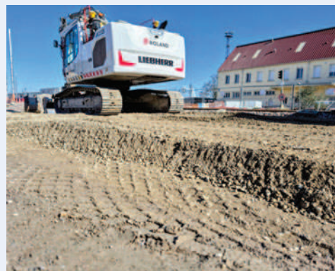
Création de voirie d'accès en grave béton 0/31,5
