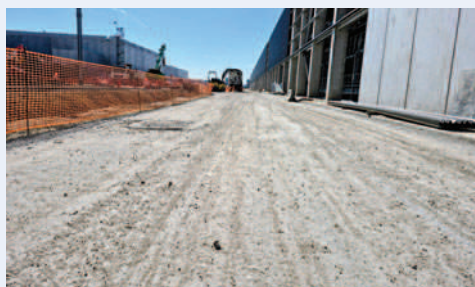
Voie d'accès le long du nouveau bâtiment de maintenance
